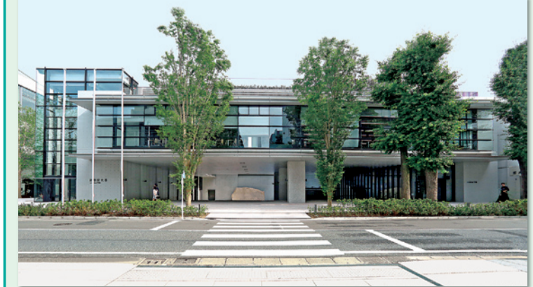
5号館(写真提供:日刊建設工業新聞)
